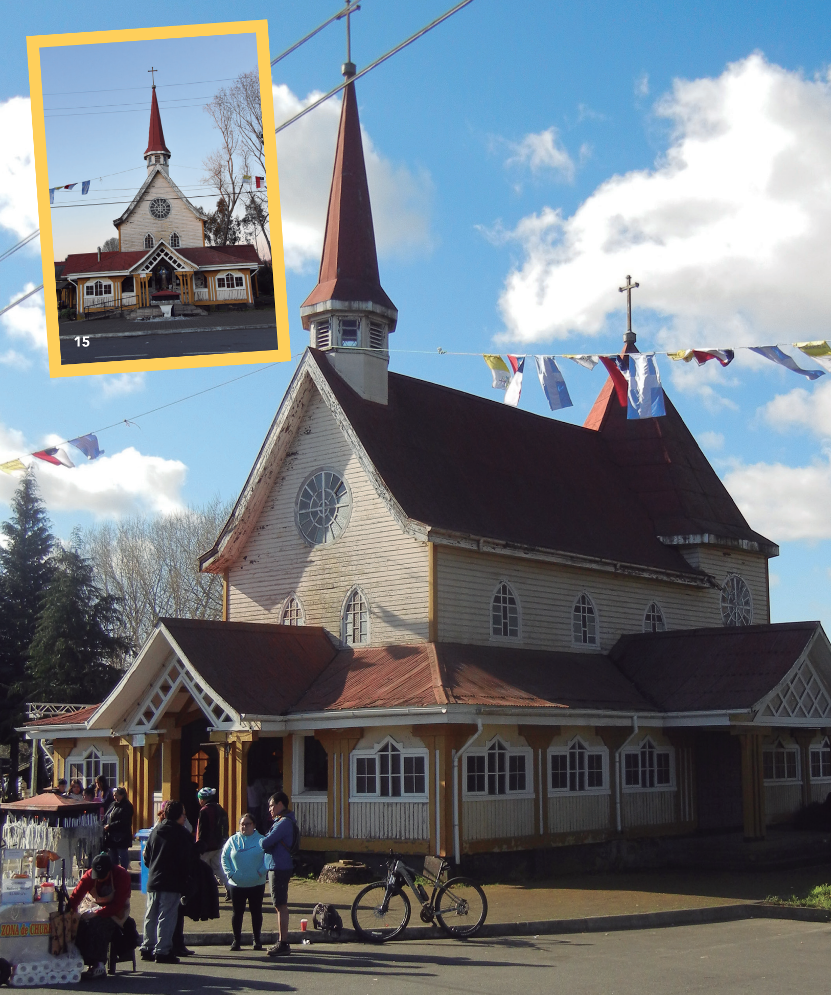
14. Capilla San Conrado, Villa García, Cunco. Fotografía CENPUC. 15 y 16. Santuario Virgen del Tránsito, Metrenco. Fotografía CENPUC.
