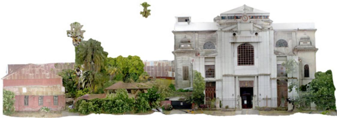
Figura 42. Elevación frontal del conjunto franciscano de Chillán en donde se puede apreciar la desviación en la vertical del templo. (Levantamiento fotogramétrico realizado para el Centro del Patrimonio UC por Tomás Bravo, 2020)
